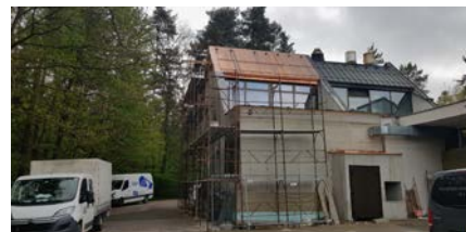
Gradnja prizidka se je pričela januarja letos.
